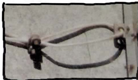
FIG. 3-D Cable loop
